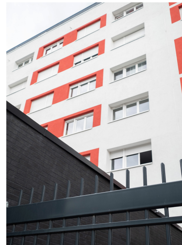
Copropriété Sadi Carnot, Aubervilliers
