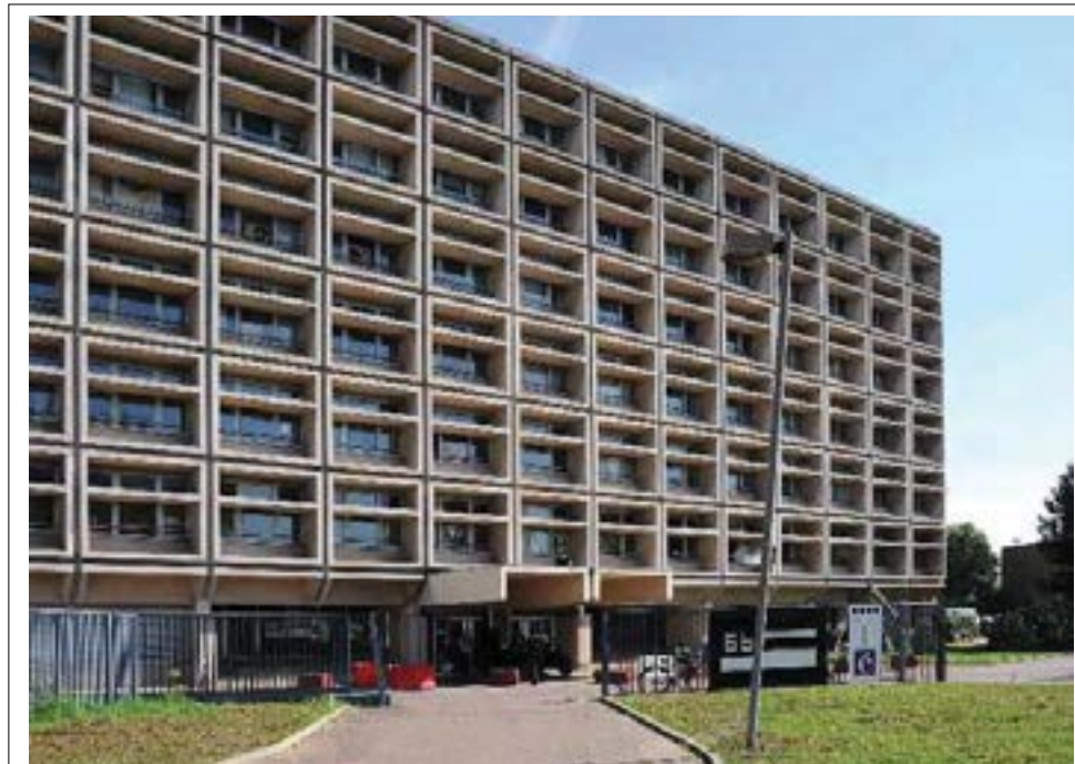
Ci-contre : façade principale. Ci-après : vues en détail de l'entrée. Jacques MANGIN – UASD – Département de la Seine-Saint-Denis
