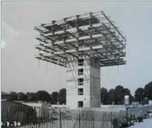
Principe constructif des planchers suspendus au noyau central ; pose des panneaux d'aluminium en façade ; et bâtiment lors de sa réception. Archives IFA
