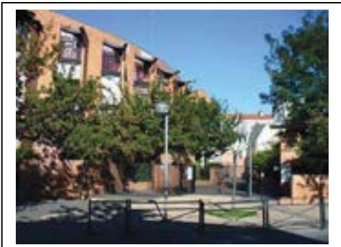
L'entrée principale, passage de la Colombe, à droite de l'entrée une sculpture de R. Porro. Département de la Seine-Saint-Denis, DCPSL, SPC
