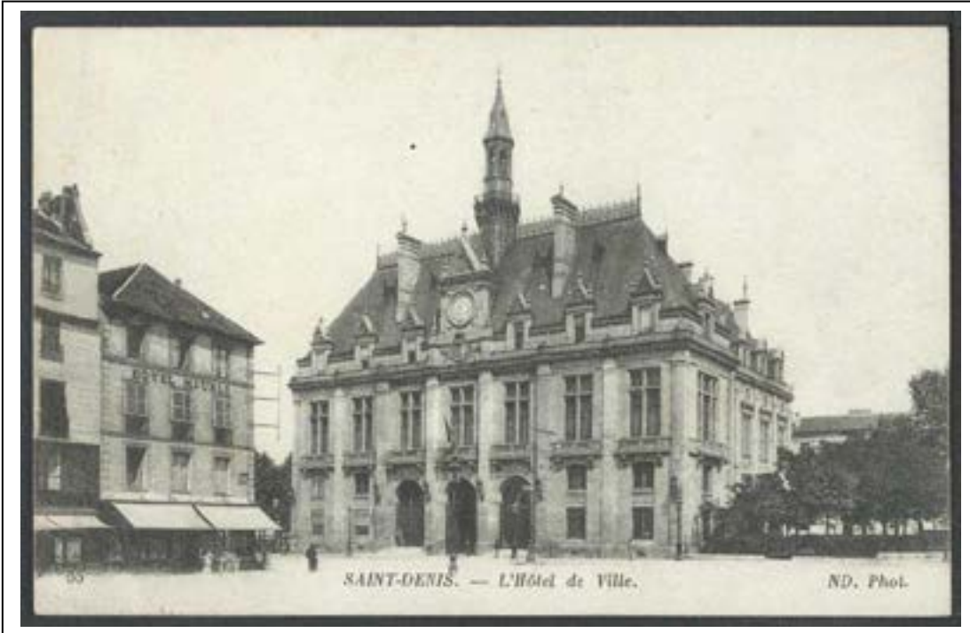
AD93, 2 Fi Saint-Denis 84, carte postale voyagee en 1917 : sur cette vue les modifications de la toiture sont perceptibles.
