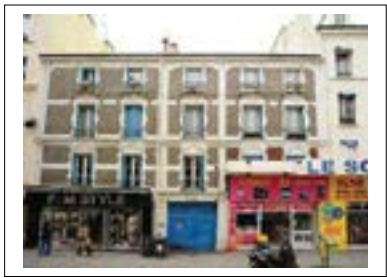
Façade sur la rue Gabriel Péri Département de la Seine-Saint-Denis, DCPSL, SPC
