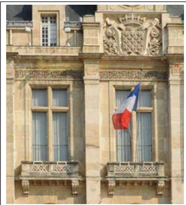
Détail du traitement soigné de la pierre sculptée Département de la Seine-Saint-Denis, DCPSTL, SPC
