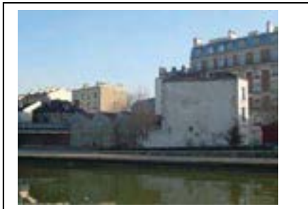
Quai du port à la hauteur du Bon Coin et de son mur aveugle donnant sur les berges.
