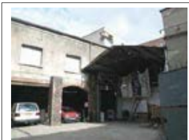
Façade sur cour du bâtiment E et de l'aire couverte de stockage F Département de la Seine-Saint-Denis, DCPSL, SPC
