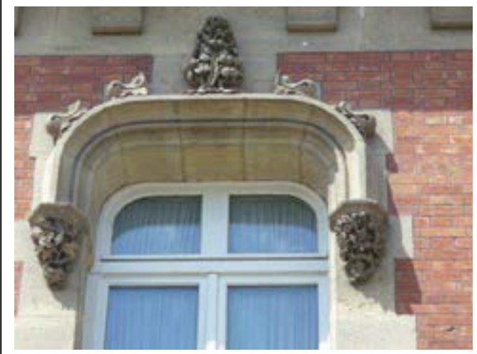
Bâtiment principal, avant-corps (façade est) : détail d'une baie Département de la Seine-Saint-Denis, DCPSL, SPC
