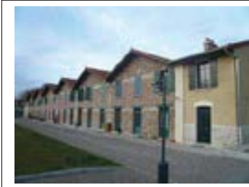
Façade depuis l'entrée des logements B1 et B3 Département de la Seine-Saint-Denis. DCPSL. SPC
