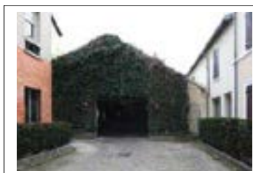
Façade sur cour du lavoir © Jacques MANGIN-UASD-Département de la Seine-Saint-Denis
