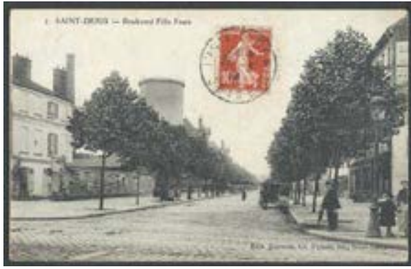
Ci-contre : vue du boulevard Félix Faure avant la construction de la piscine avec au 2 nd plan la machine élévatoire des eaux. AD93. cote2F130
