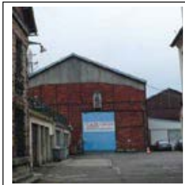
Pignon sur cour de la grande halle. Département de la Seine-Saint-Denis ©
