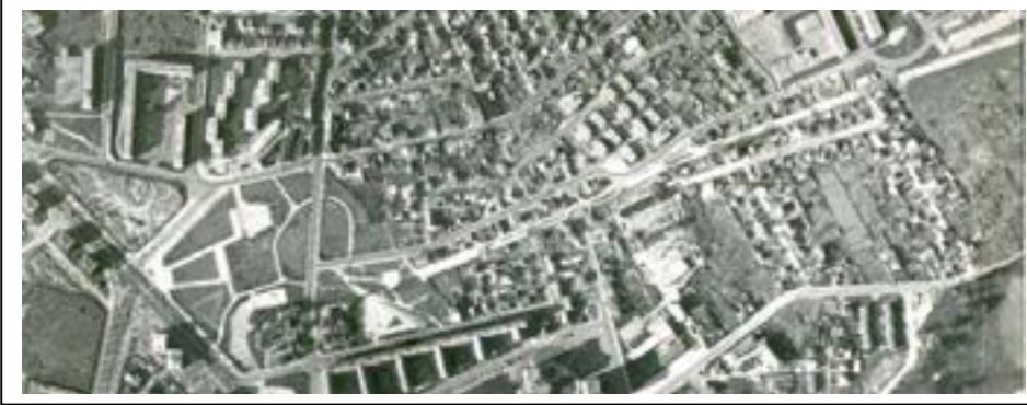
L'aménagement réalisé, vers 1970 : le parc M. Cachin et la promenade de la Vieille Mer Direction de l'Urbanisme, Ville de Saint-Denis
