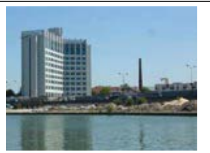
Perspective sur la cheminée depuis le bassin.
