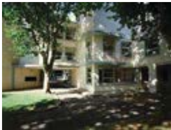
Façade sur le mail Département de la Seine-Saint-Denis, DCPSL, SPC
