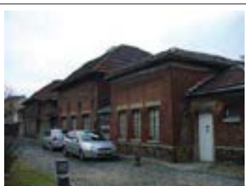
L'aile des services techniques composée d'une succession de sept pavillons articulés autour d'une aile centrale. Département de la Seine-Saint-Denis, DCPSL, SPC
