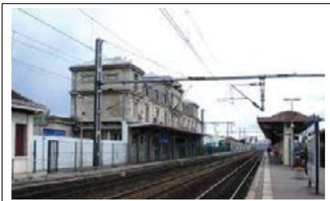
Vue du bâtiment de voyageurs A depuis la place et depuis les quais (détail des mosaïques) Jacques MANGIN – UASD 6 Département de Seine-Saint-Denis
