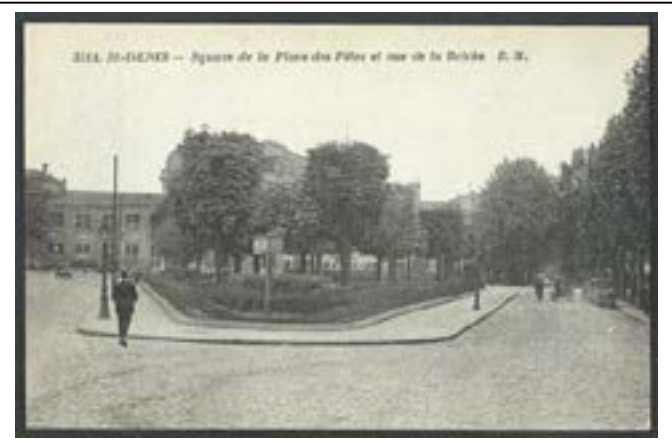
AD 93, 2 Fi Saint-Denis 844. Carte postale ancienne s.d. Les aménagements d'origine devant la Salle des Fêtes.
