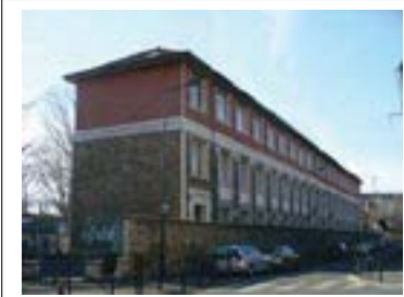
Façade sur la rue Simon Département de la Seine-Saint-Denis, DCPSL, SPC
