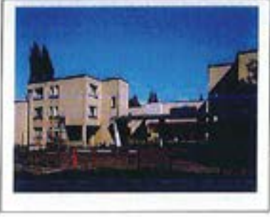
Façades sur rue. Photographie J.B. Valère Département de la Seine-Saint-Denis / Région Île-de-France, ADGAP, 2008
