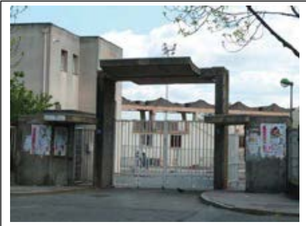
Portail d'entrée 5-7 rue du 19 Mars 1962 situé à l'arrière de la petite tribune Département de la Seine-Saint-Denis, DCPSL, SPC
