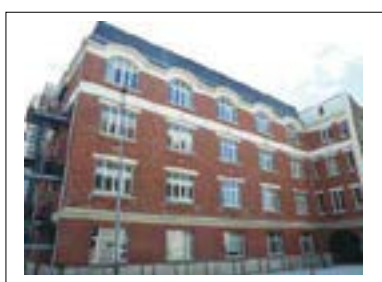
Façade nord. Département de la Seine-Saint-Denis, DCPSL, SPC
