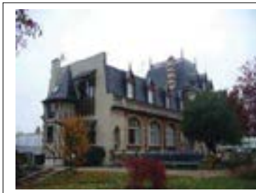
Façade sur sud et ouest Département de la Seine-Saint-Denis, DCPSL, SPC
