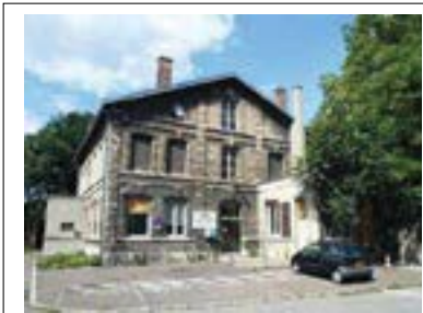
Façade sur l'impasse Département de la Seine-Saint-Denis, DCPSL, SPC
