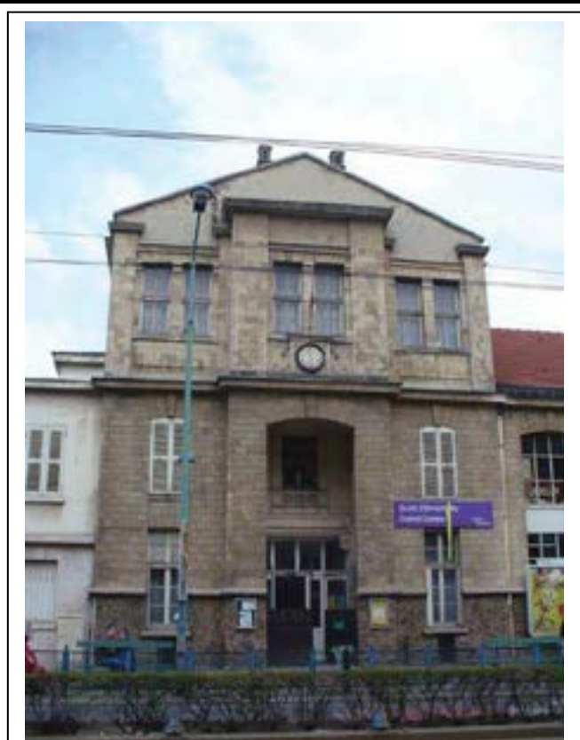
Pavillon latéral Ouest de l'école boulevard Félix Faure Département de la Seine-Saint-Denis, DCPSL, SPC
