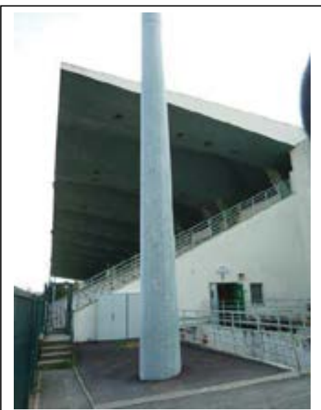
Porte-à-faux en béton réalisé au moyen de la voile mince autoportante (grande tribune) Département de la Seine-Saint-Denis, DCPSL, SPC
