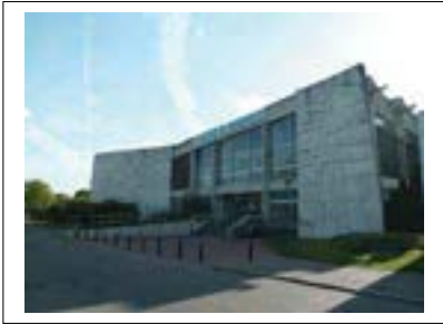
Piscine interdépartementale de Marville (E) Façade est (entrée) Département de la Seine-Saint-Denis, DCPSL, SPC
