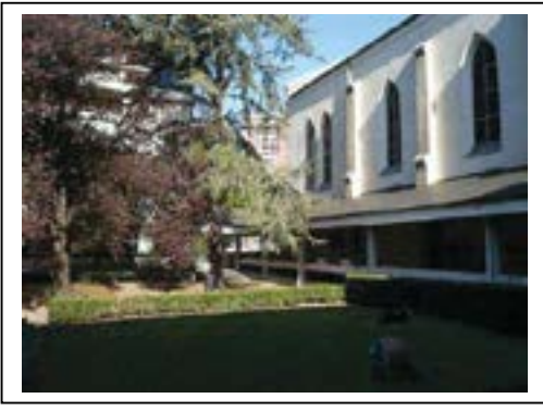
La chapelle réhabilitée vue depuis le cloître. Département de la Seine-Saint-Denis, DCPSL, SPC
