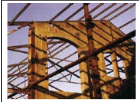
Intérieur de la halle en cours de chantier, probable façade d'origine avant extension des années 1880 Département de la Seine-Saint-Denis, DCPSL, SPC
