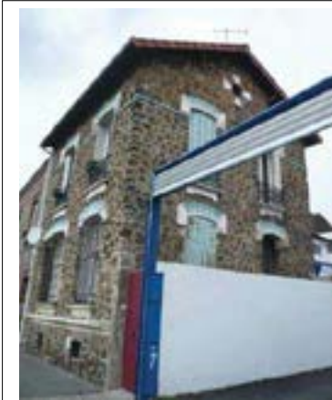
Façade sur la rue du Landy Département de la Seine-Saint-Denis, DCPSL, SPC
