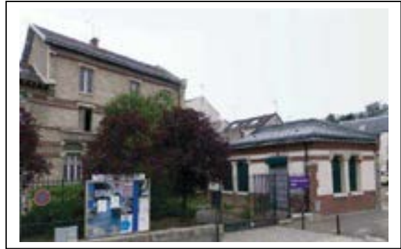
Boulevard Anatole France, ci-dessus : l'ancienne école maternelle aujourd'hui centre de loisirs. A droite, un pavillon d'entrée dont le pendant boulevard de la Libération a été démoli. Ci-contre : l'ancienne école de filles, boulevard Anatole France. Département de la Seine-Saint-Denis, DCPSL, SPC
