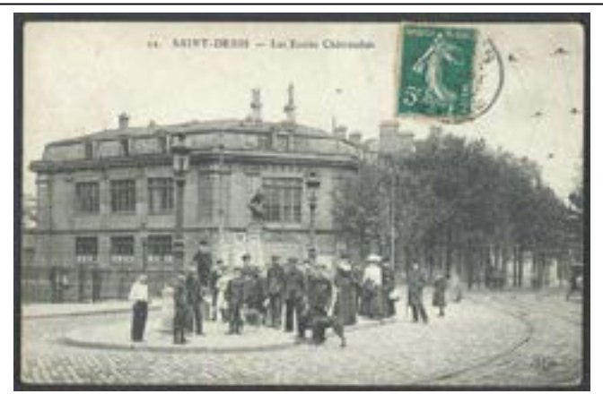
AD 93, 2 Fi Saint-Denis 839. Carte postale ancienne s.d. L'école de garçons à l'angle de la rue Suger et du boulevard Jules Guesde.
