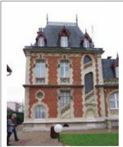
Façade nord, avant-corps Département de la Seine-Saint-Denis, DCPSL, SPC
