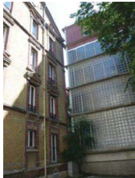
Rue des Chaumettes, en retrait de la rue, le second bâtiment du parking. Département de la Seine-Saint-Denis, DCPSL, SPC
