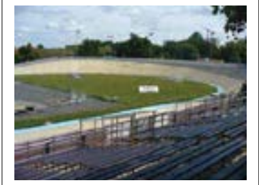
Vue de la piste Département de la Seine-Saint-Denis, DCPSL, SPC
