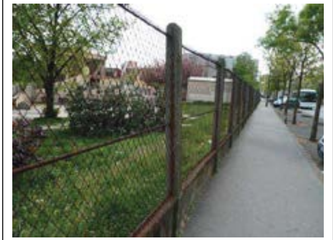
Clôture du stade Département de la Seine-Saint-Denis, DCPSL, SPC
