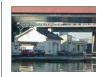
Ecluse 5, bâtiments G (maison éclésièrre de première génération, en-haut) et H (en bas).
