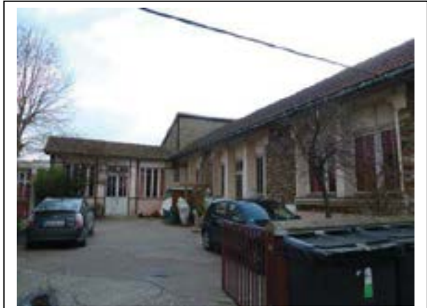
Ci-dessus : à droite ancienne école maternelle, au fond petit bâtiment léger aujourd'hui rattaché au centre médico Psycho-Pédagogique C. Claudel. Département de la Seine-Saint-Denis, DCPSL, SPC
