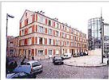
Façade sur rue Jeanne Margit - UNED - Département de Seine-Saint-Denis
