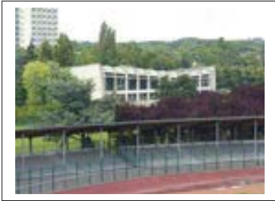
Piscine interdépartementale de Marville (E) Façade sud Département de la Seine-Saint-Denis, DCPSL, SPC
