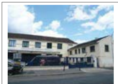
Façade sur la rue du Landy Département de la Seine-Saint-Denis, DCPSL, SPC
