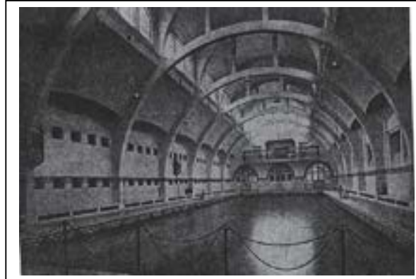
Ci-dessus : L'intérieur du bassin de la piscine de la Butte-aux-Cailles construite en 1924 à Paris par L. Bonnier. Architecture d'Aujourd'hui , avril 1934, p.59
