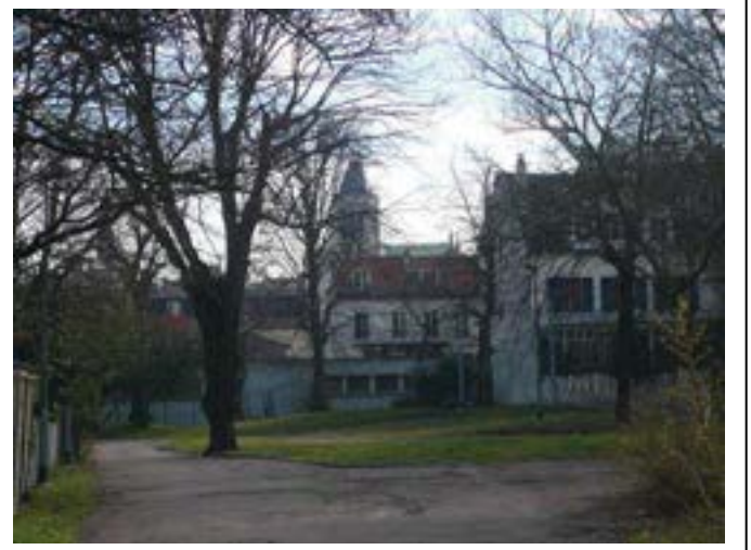
Ci-contre à gauche : début 2010 vue de la façade postérieure du bâtiment de la Poste depuis la rue de l'ancienne salle de spectacles « Saint-Denis kermesse ». Département de la Seine-Saint-Denis, DCPSL, SPC
