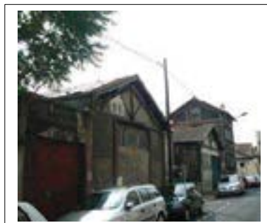
Façade sur rue de l'atelier C Département de la Seine-Saint-Denis, DCPSL, SPC
