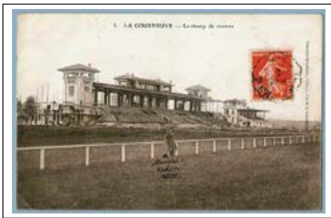
La Courneuve – Champ de Courses. Tribune en cours de construction, vers 1913. Service documentation archives de la Courneuve 8Fi0131
