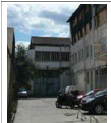
Façade sur cour des ateliers B Département de la Seine-Saint-Denis, DCPSL, SPC
