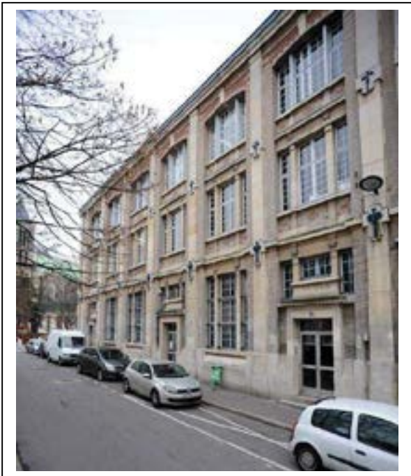
Aile sud de la salle de Réunions. Département de la Seine-Saint-Denis, DCPSL, SPC
