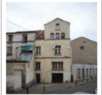
Façade sur rue Albert Walter Département de la Seine-Saint-Denis, DCPSL, SPC
