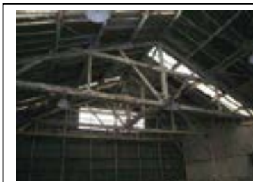
Charpente en bois de la halle. Département de la Seine-Saint-Denis
