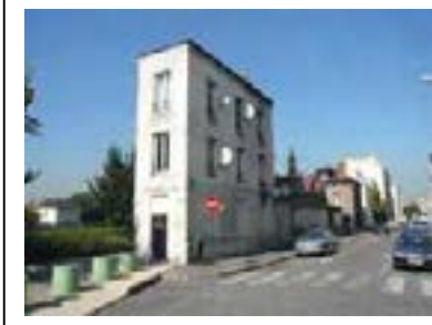
Façade sur rue du bâtiment A Département de la Seine-Saint-Denis, DCPSL, SFC
