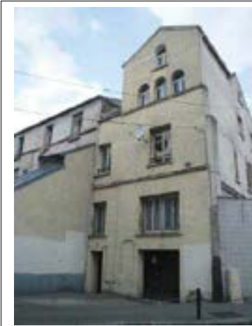
Façade sur rue Albert Walter © Street view Google
