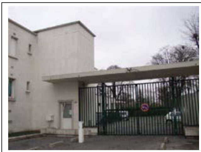
Détail de l'une des entrées latérales, adossées aux logements de fonction et, à l'origine, une des portes principales.
