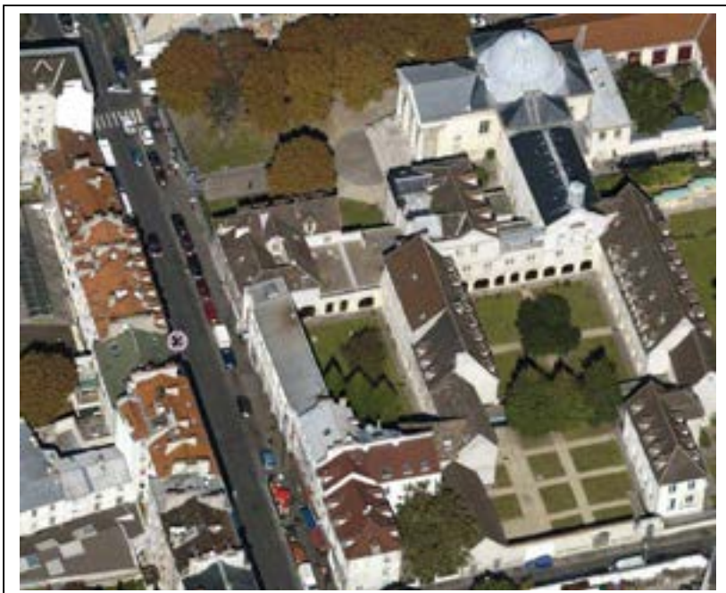
Vues de détail et d'ensemble du bâtiment, ainsi que son inscription dans l'ilot de l'ancien couvent. Département de la Seine-Saint-Denis, DCPSL SPC. © Jacques MANGIN - UASD - Département de la Seine-Saint-Denis. IA Obliques 2008 © InterAlias 2009
