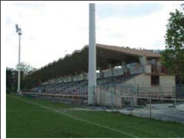
Façade avant de la petite tribune Département de la Seine-Saint-Denis, DCPSL, SPC
