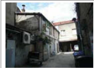
Façade sur cour depuis le passage. Au fond le bâtiment E Département de la Seine-Saint-Denis, DCPSL, SPC
