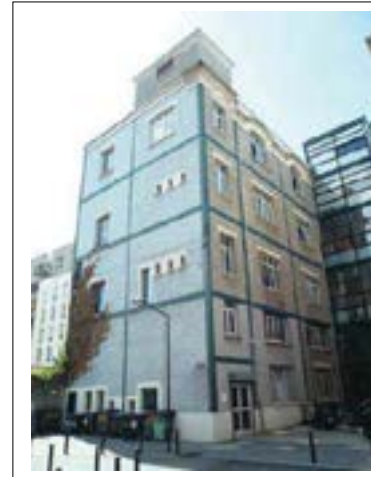
Façade sur cour, vue de la machinerie du monte charge. Département de la Seine-Saint-Denis, DCPSL, SPC
