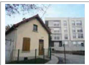
Façade ouest, chemin d'accès à la cité Département de la Seine-Saint-Denis, DCPSL, SPC
