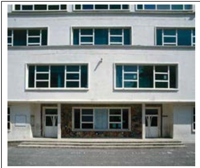
Détail de la façade principale, avec la mosaïque en rez-de-chaussée.
