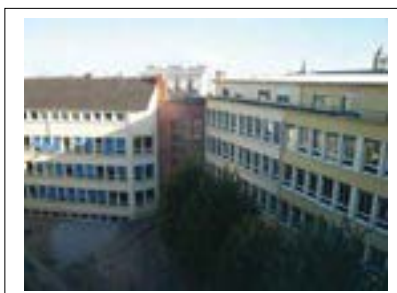
Façade du bâtiment 9 rue des Ursulines (en haut) et façades du bâtiment sur la cour (en bas). H1 Département de la Seine-Saint-Denis, DCPSL, SPC
