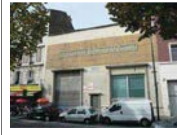
Façade sur l'avenue du Président Wilson Département de la Seine-Saint-Denis, DCPSL, SPC
