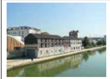
Façade sur le canal Département de la Seine-Saint-Denis, DCPSL, SPC
