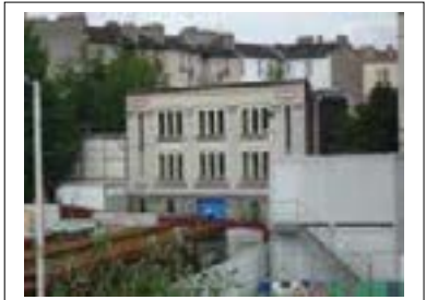
Façade sur la rue Brise Echalias Département de la Seine-Saint-Denis, DCPSL, SPC
